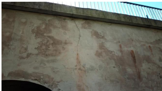
-Trhlina přes římsu a čelní zeď
