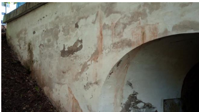
-Výluhy, zavlhlá celá konstrukce
